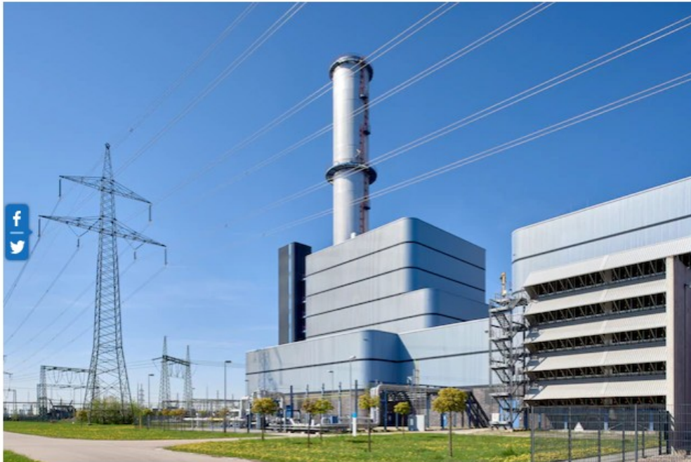
Gas- und Dampfturbinenkraftwerk Irsching
